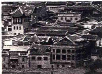
图 1.2 开埠时期的建筑
