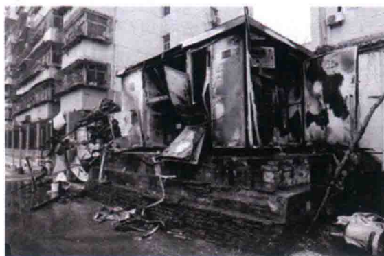
图 1-5 三相不平衡引起的变压器烧毁
