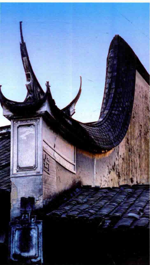
福州民居的马鞍墙，位于闽清宏琳厝
