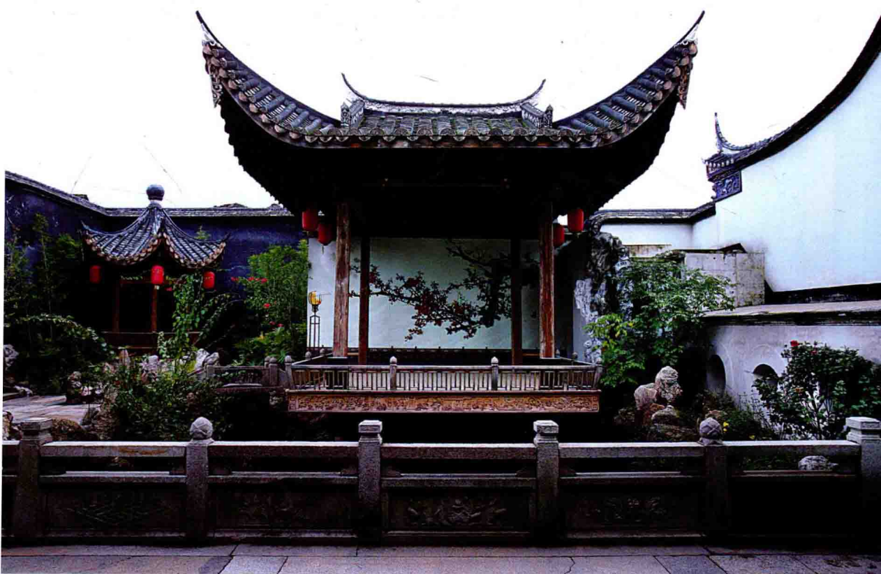
三坊七巷水榭戏台
