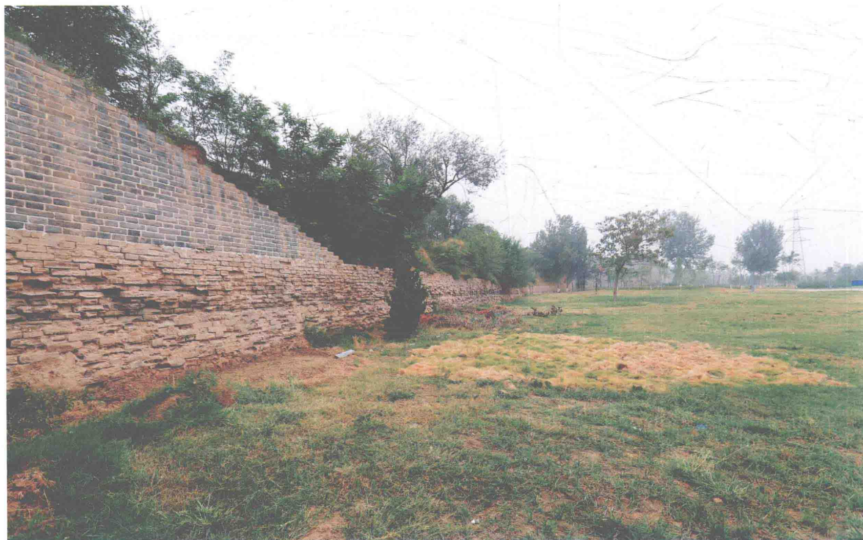
开封南城墙外侧环境
