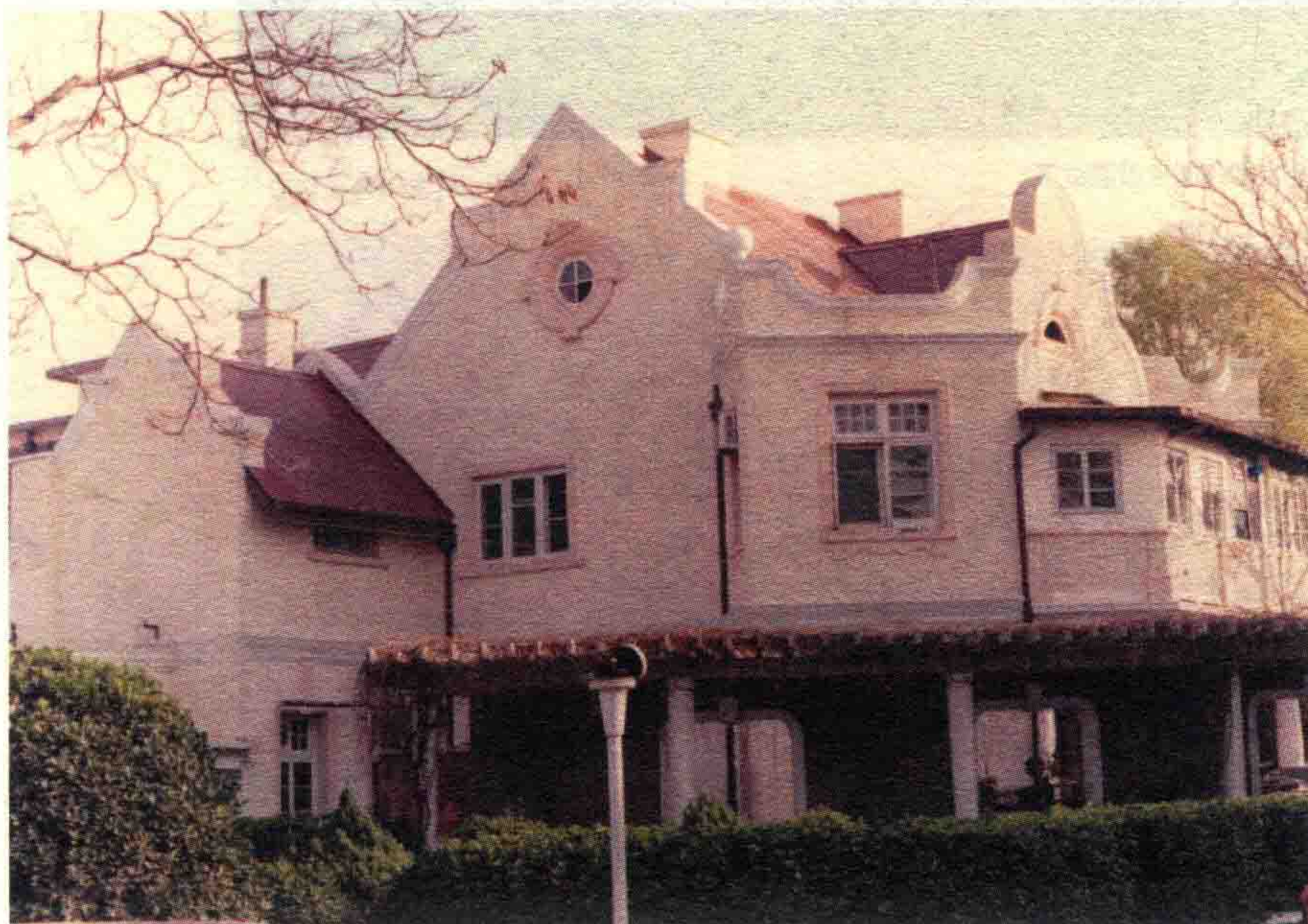
天津小洋楼山墙
