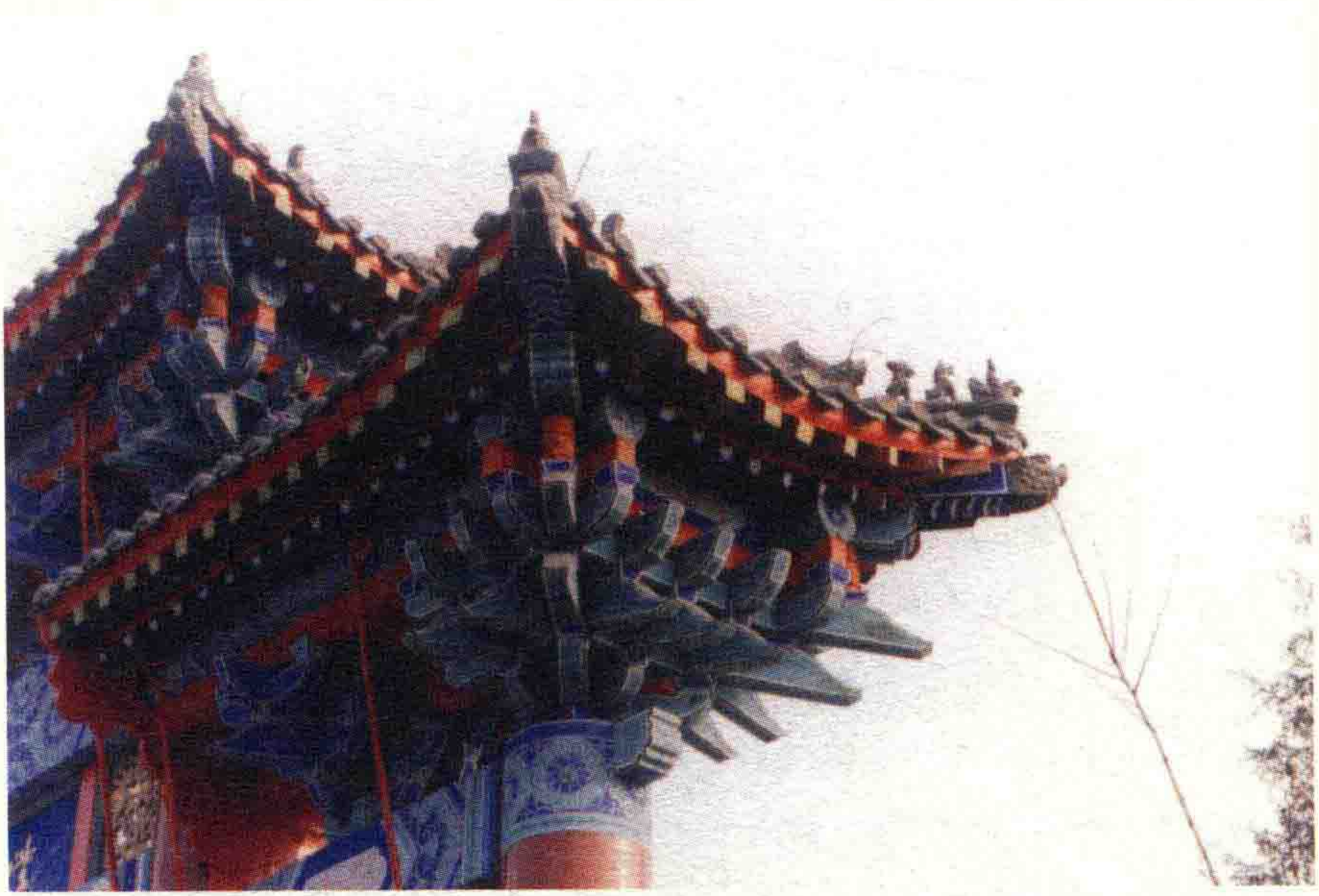
天津盘山牌楼檐角
