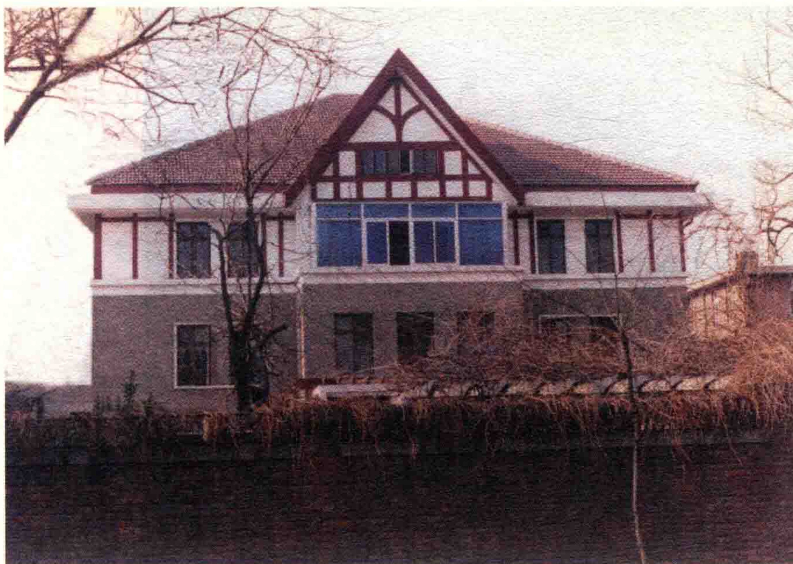
天津小洋楼坡顶
