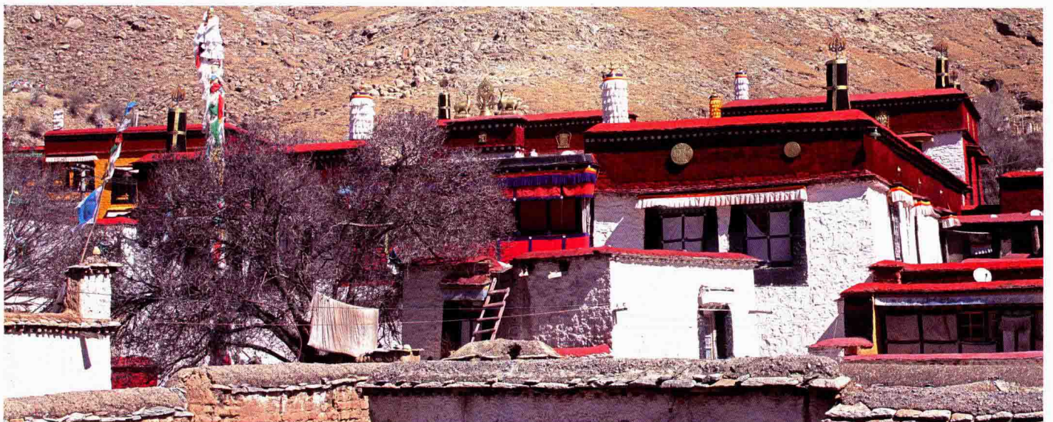
拉萨市曲水县热堆寺建筑局部
