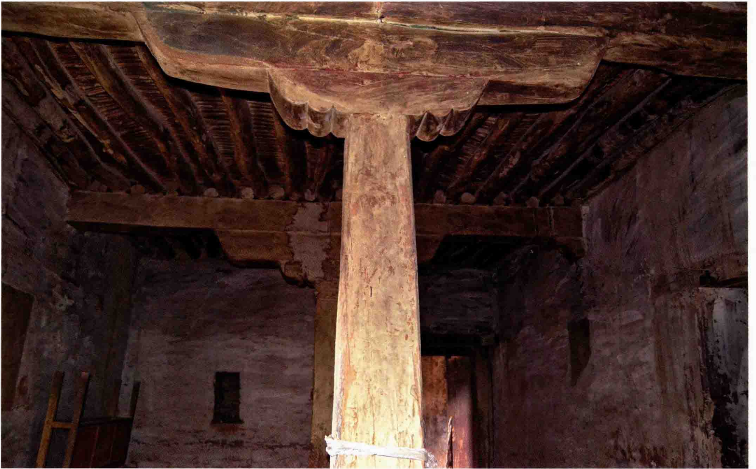
山南市扎囊县葱堆措巴外环廊建筑内木构件
