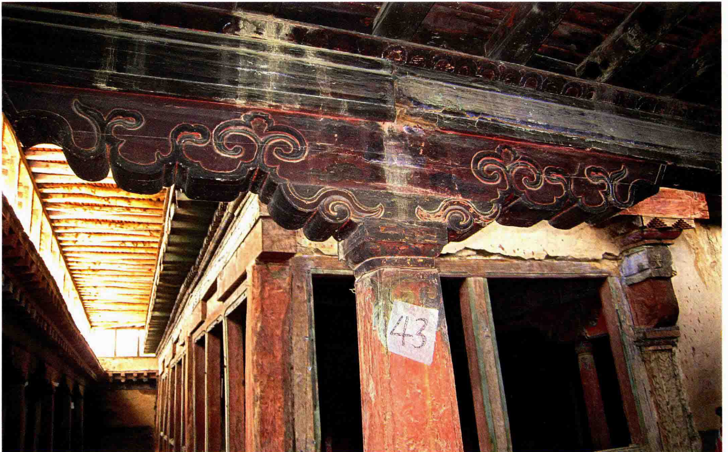
山南市扎囊县结林措巴主体建筑木构件
