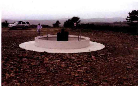
风电场平台砾石裸地
