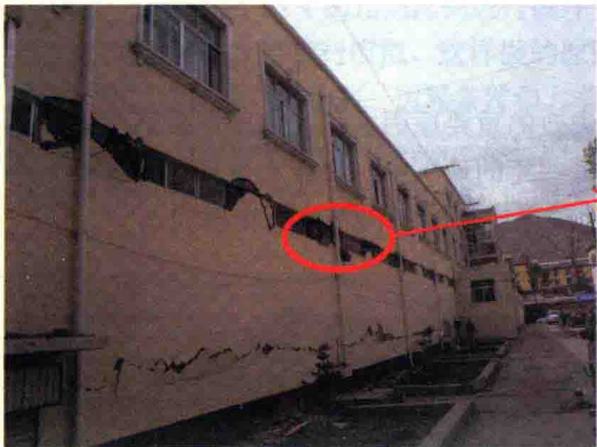
照片 2.15 结古镇震害—剪跨比小—短柱—剪切破坏
