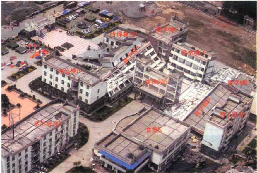
照片 1.4 漩口中学震后面貌
