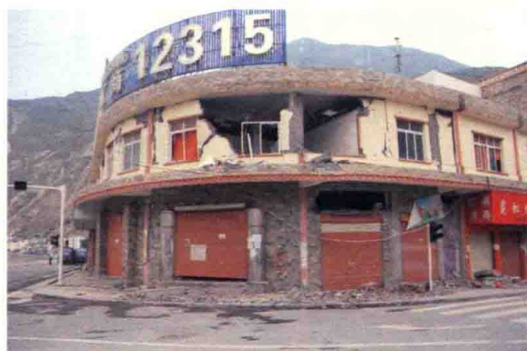
照片 2.4 圆弧填充墙很容易出平面破坏
