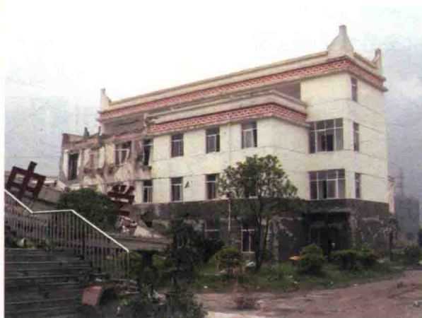
照片 1.5 漩口中学办公楼——内走廊框架结构
