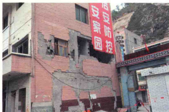
照片 2.3 填充墙出平面破坏
