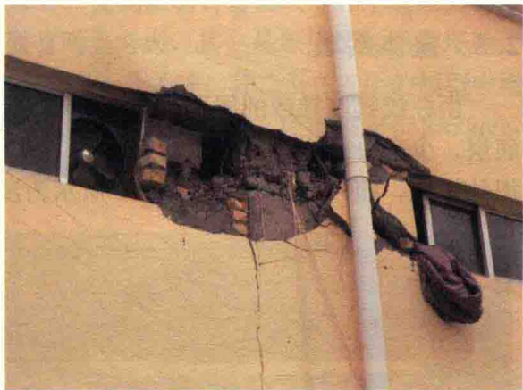
照片 2.15 结古镇震害—剪跨比小—短柱—剪切破坏
