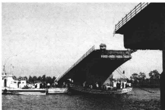
图 1-1 超限超载运输引起的桥梁垮塌事故
