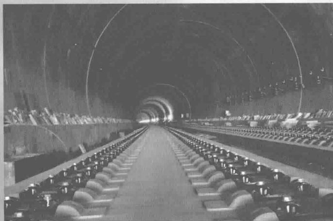
南龙铁路 II 标段端西隧道无砟轨道
