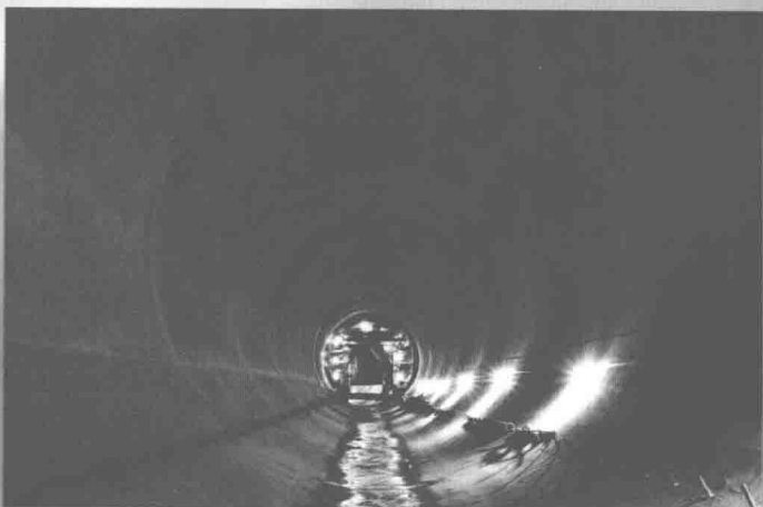
海南琼中抽水蓄能电站土建主体工程 C3 标中平洞 钢模台车衬砌混凝土施工
