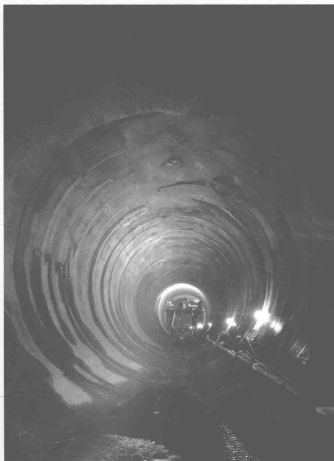
深圳抽水蓄能电站水道及厂房系统土建工程Ⅱ标中平洞上游侧水泥固结灌浆
