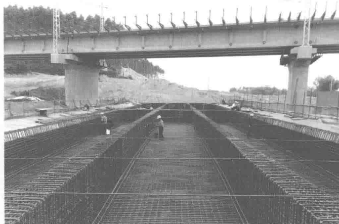
江门市台开路道路工程项目下穿深茂桥现浇箱梁底板钢筋绑扎
