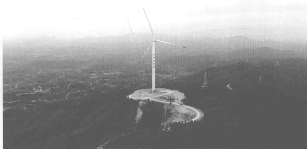
中电建阳江阳东农垦局宝山风电场项目一期 24 号风力发电机组
