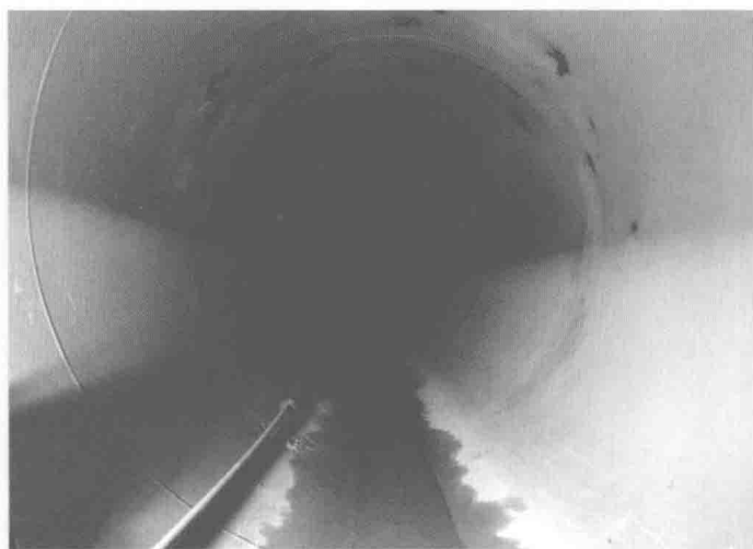
深圳抽水蓄能电站水道及厂房系统土建工程Ⅱ标4号压力钢管内支撑拆除施工
