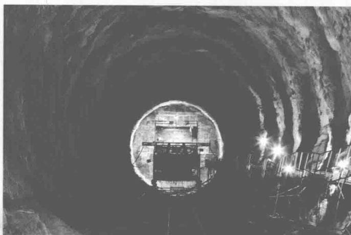
海南琼中抽水蓄能电站土建主体工程 C3 标引水斜 井全断面扩挖
