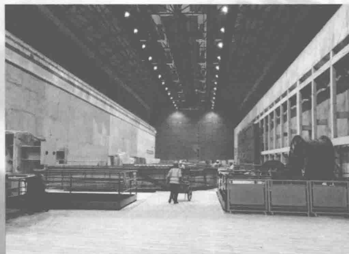
清远抽水蓄能电站水道与厂房系统土建工程Ⅱ标主厂房发电机层安全防护
