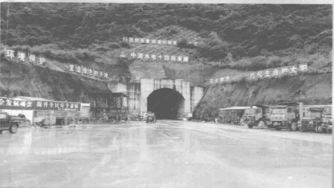
惠州国储 500 万 \text{m}^3 地下水封洞库项目地下工程储 油洞罐 (0301 单元) 第 III 标段洞口全貌
