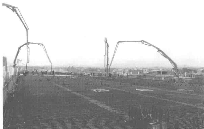
国道 319 线漳州段改线一期工程流传特大桥第 24 联现浇梁浇筑
