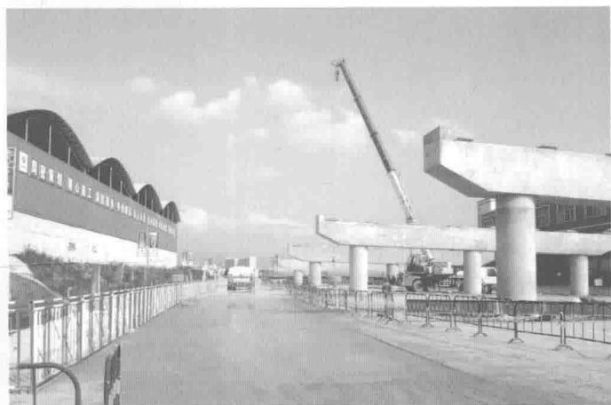
江门市台开路道路工程项目 S273 跨线桥施工
