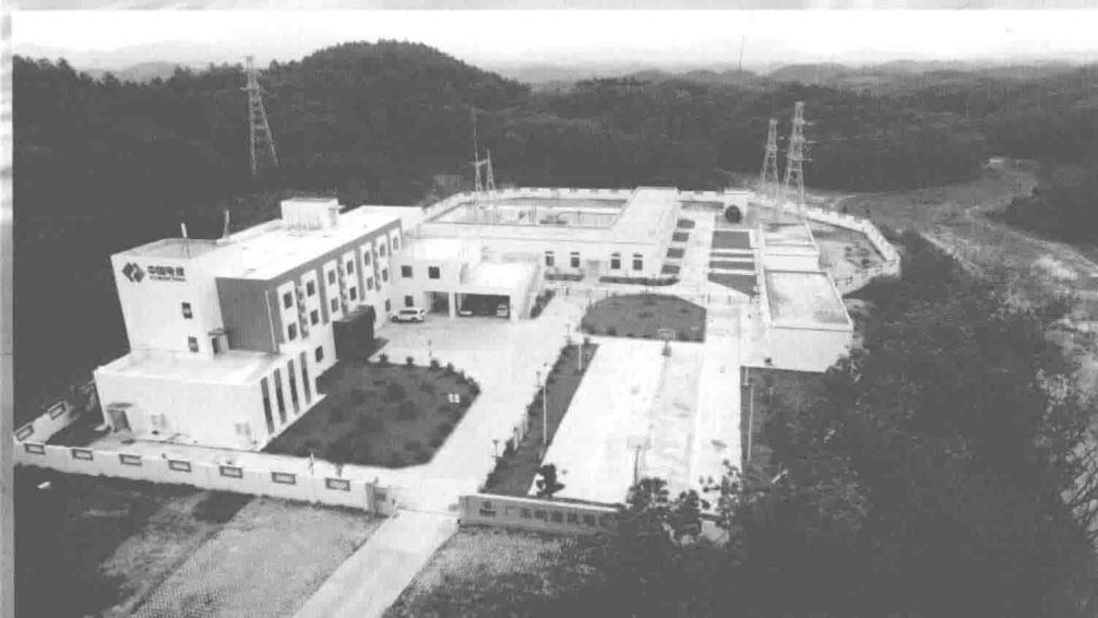
中电建阳江阳东农垦局宝山风电场项目已建成升压站
