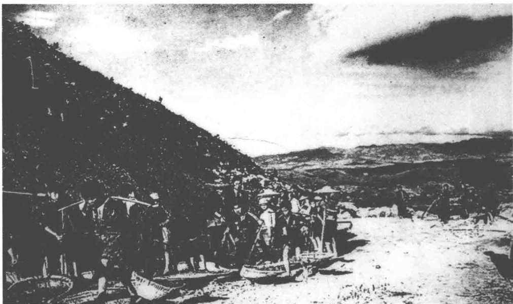
■ 云南省群众正在热火朝天地赶修滇缅公路。
