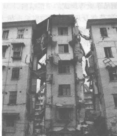
图 1.9 砌体结构毁损
