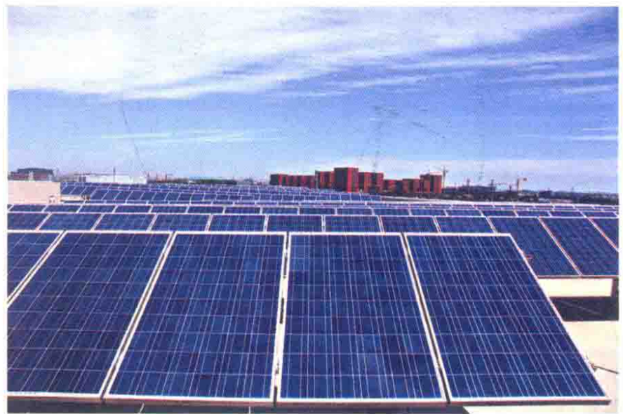
7月26日，16家区内有光伏项目的企业 完成并网设备安装 投促局提供
