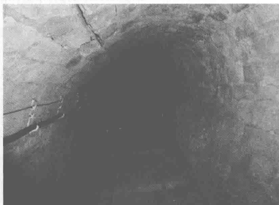
图6 运输巷道底鼓边帮顶板衬砌偏压开裂
