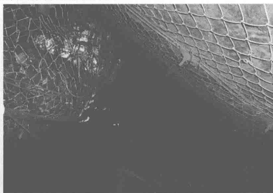
图7 运煤巷道底鼓边帮顶板严重挤压破坏（被迫停产处理）
