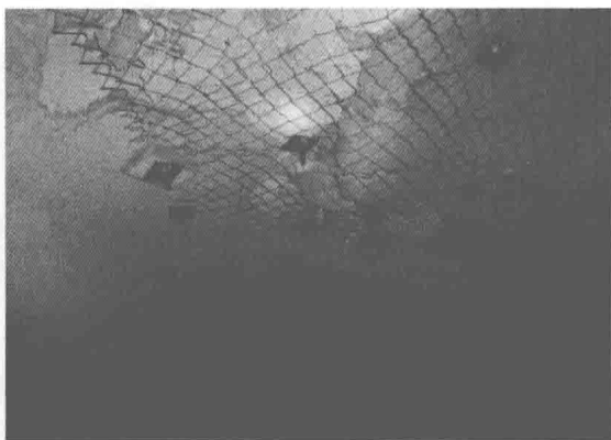
图4 运输巷道底鼓边帮破坏、顶板开裂锚网补强处理
