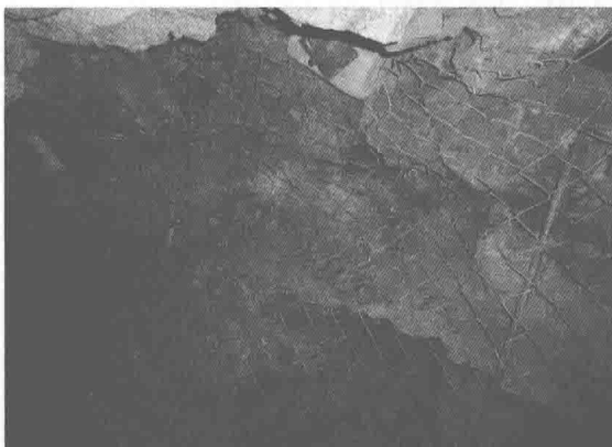
图5 运输巷道底鼓边帮顶板破坏喷浆锚网补强处理
