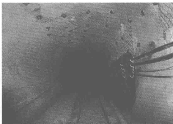
图4 运输巷道底鼓边帮破坏、顶板开裂锚网补强处理
