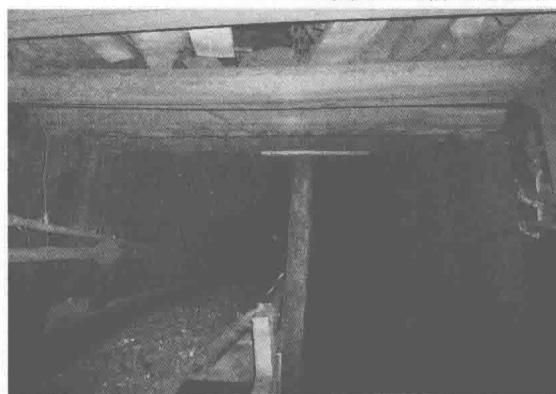
图7 运煤巷道底鼓边帮顶板严重挤压破坏（被迫停产处理）
