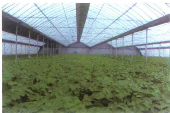
内保温连栋大棚内部
