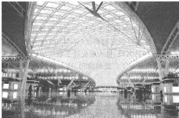
图 1-1 京广高铁广州终点站集散大厅(中央跨度 64 m)
