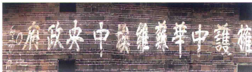
“拥护中华苏维埃中央政府”标语（原保存于赣州市章贡区水东镇七鲤村坝）
