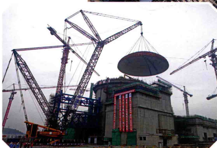
▲ 1号机组穹顶吊装
