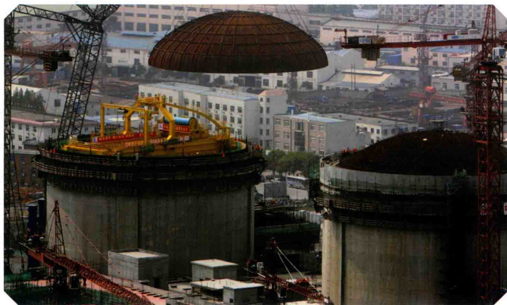
▲ 2号机组穹顶吊装
