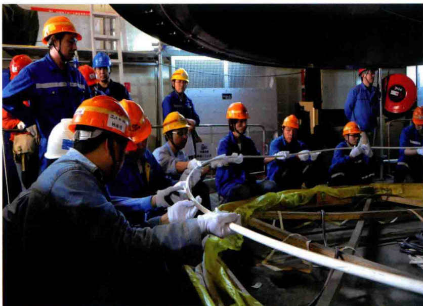
▲ 压力容器密封环安装
