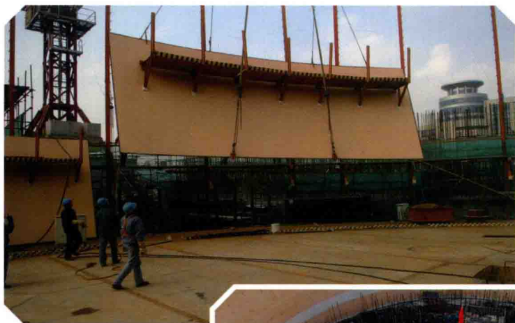
▲ 2号机组反应堆筒体钢衬里施工
