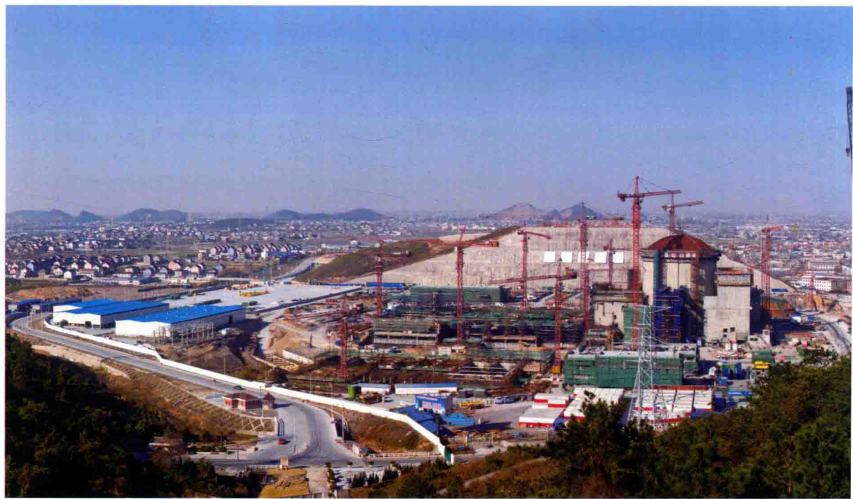
▲ 建设中的方家山核电工程
