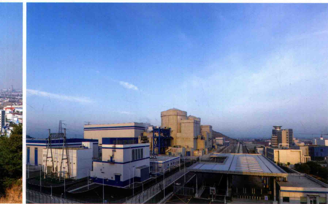
▲ 建成后的方家山核电工程
