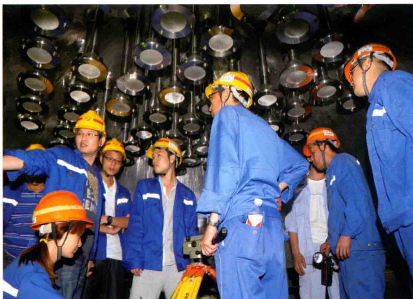
▲ 压力容器顶盖吊装前检查
