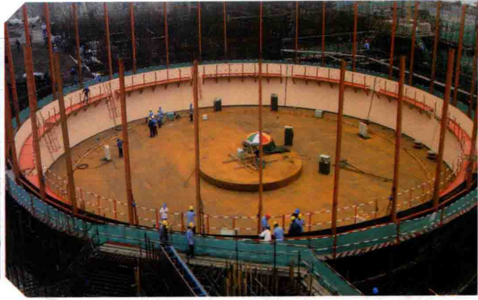
▲ 1号机组安全壳截锥体钢衬里吊装完成
