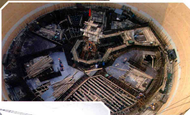
▲ 反应堆内部结构施工
