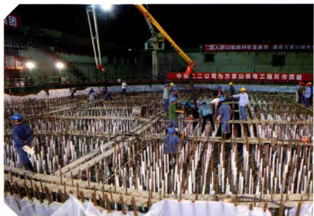
▲ 核岛底板混凝土浇注
