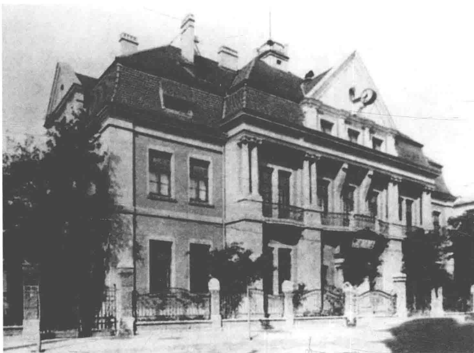
金城银行总行大楼
