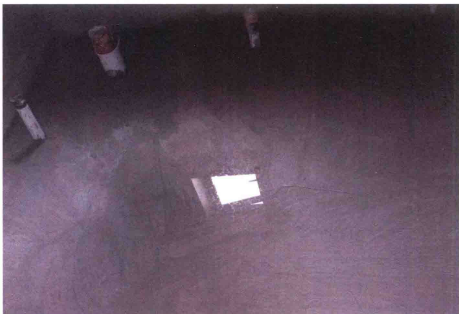
图 1-15 卫生间闭水试验
