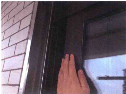
图 1-11 检查窗框接缝处的质量，不能大意
