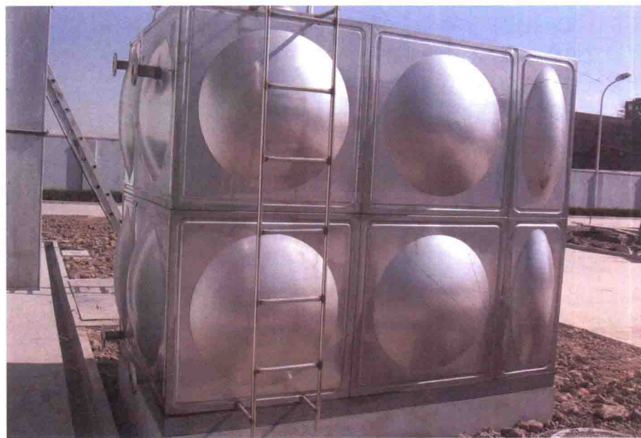
图 1-9 此类屋顶水箱间不计算建筑面积
