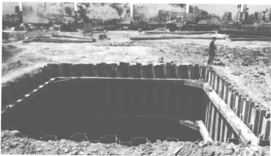
图 1-1 天津彩虹大桥工程中的格构型钢板桩 [5]
