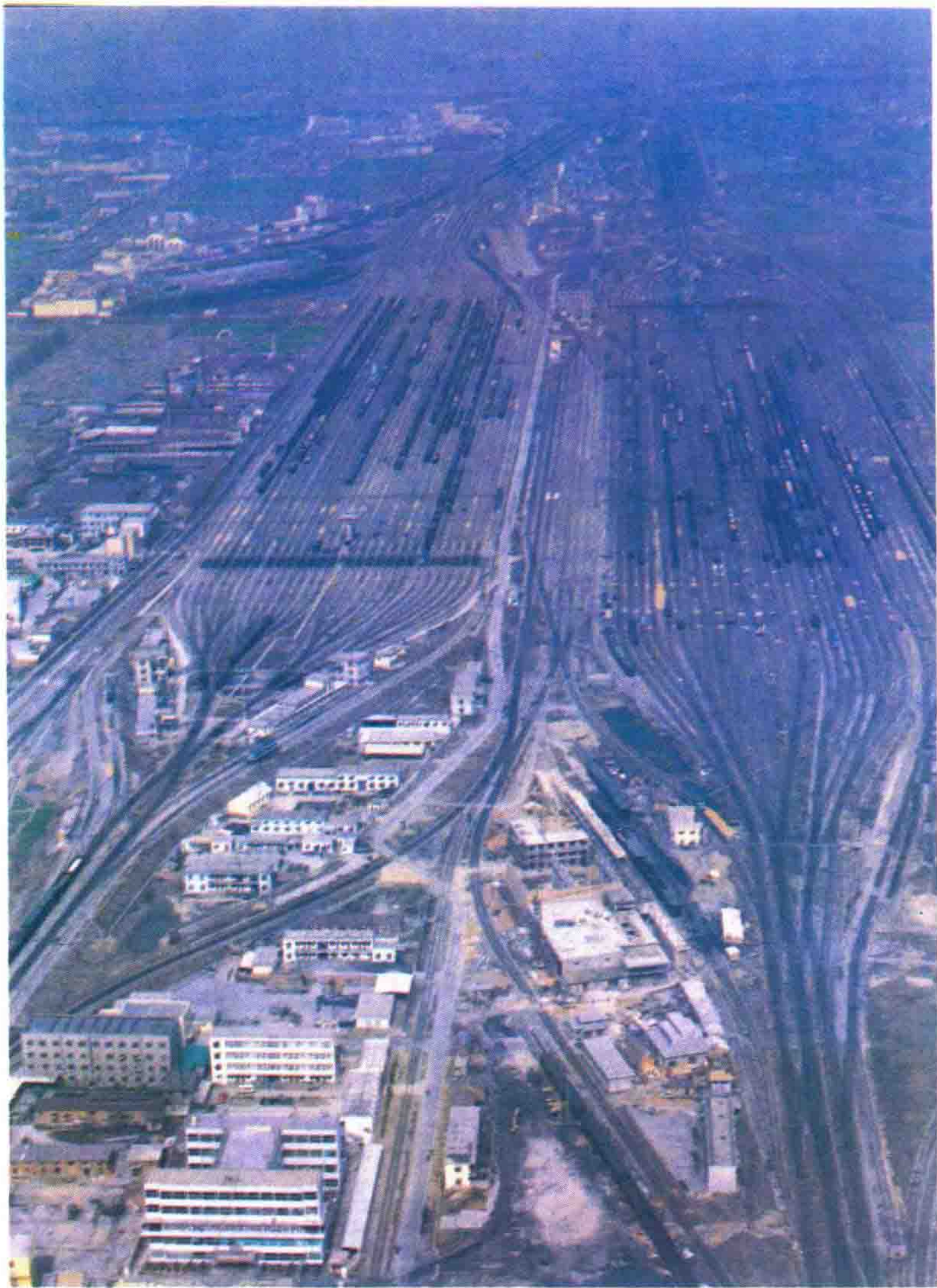
◁国家重点工程徐州铁路 枢纽孟家沟编组站
