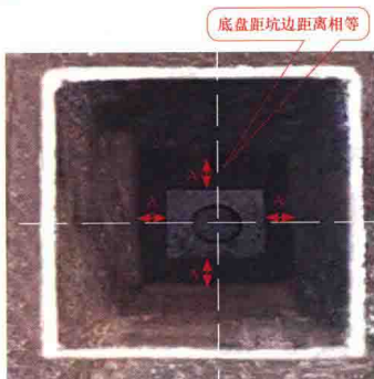
图1-1-6 底盘放在基坑中心示意图
