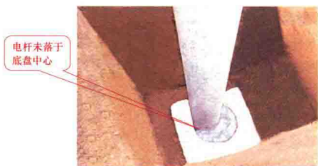
图1-2-3 电杆未落于底盘中心案例图
