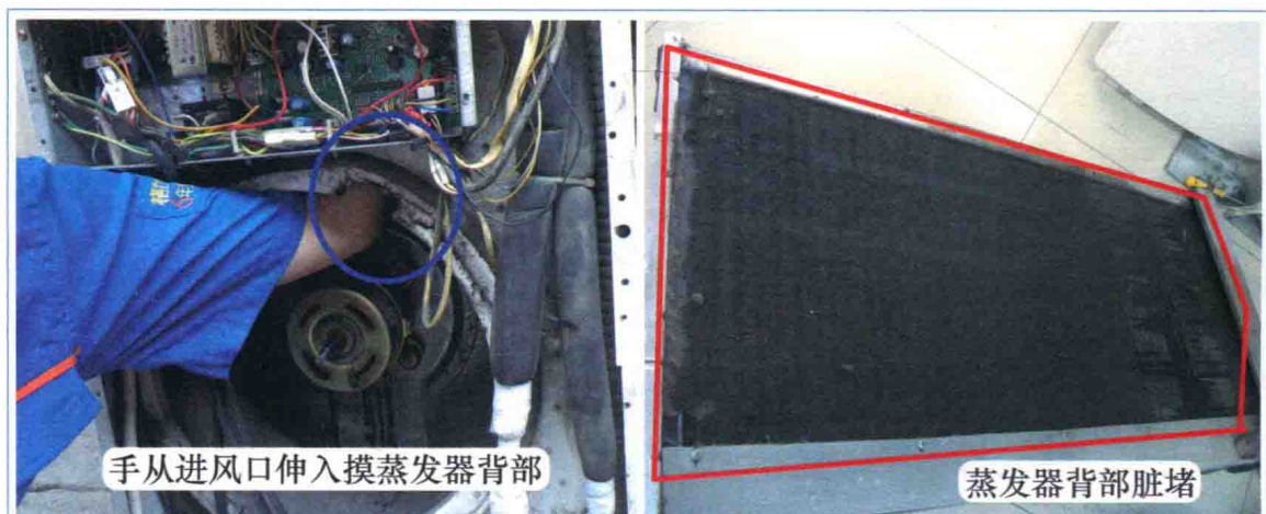
图 1-9 手摸蒸发器背部和背部脏堵
