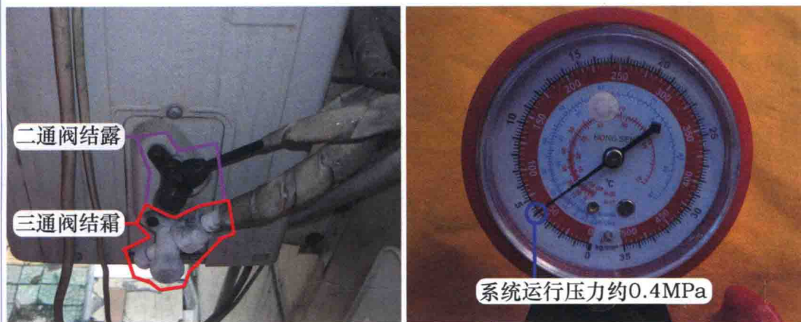
图 1-1 三通阀结霜和压力约 0.4MPa
