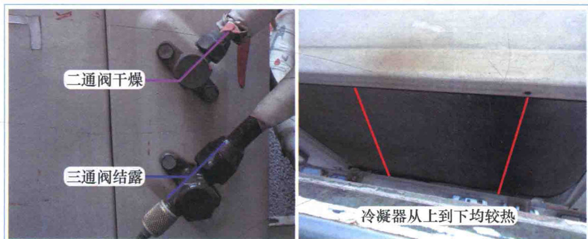
图 1-15 检查二三通阀和冷凝器
