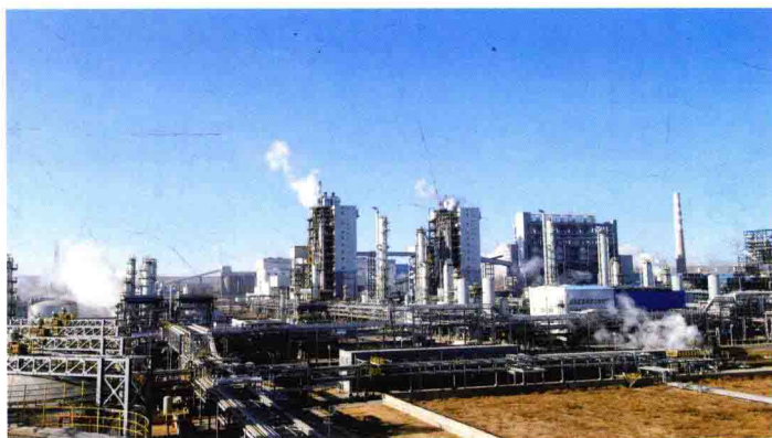
图 2.2 国内某现代煤化工煤制油企业
