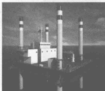
图7 拟建中的桩腿长 56 m 自升式钻探平台
