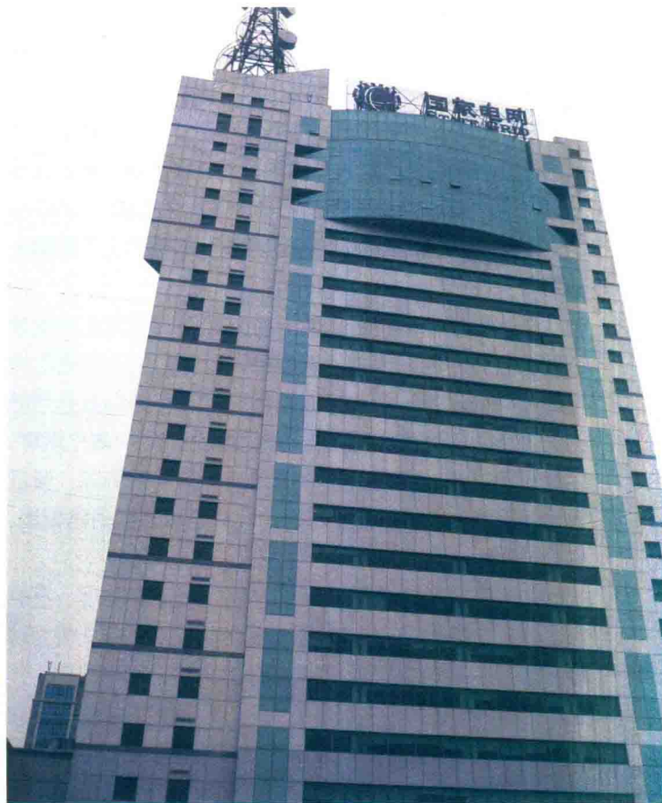
嘉兴电力局办公楼
