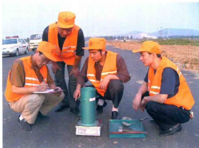
试验检测人员现场抽检
