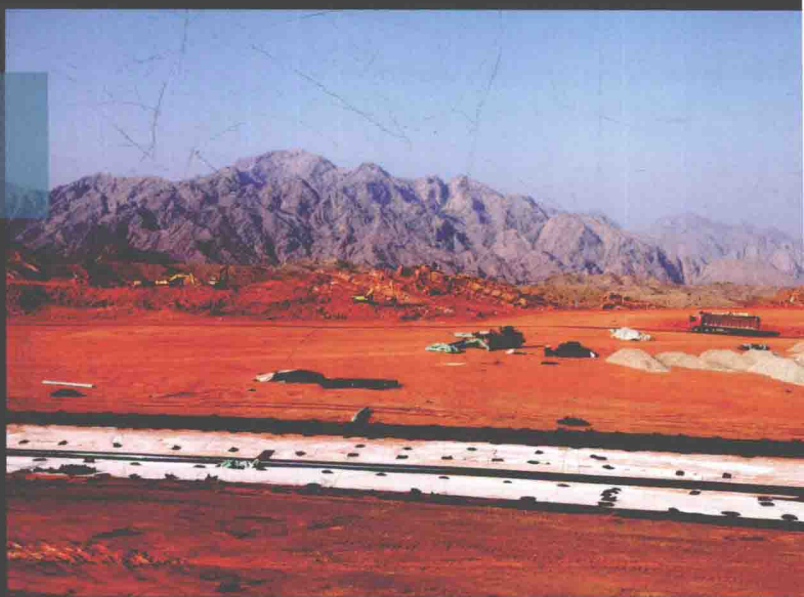
内蒙古自治区 固废处理场施 工现场
