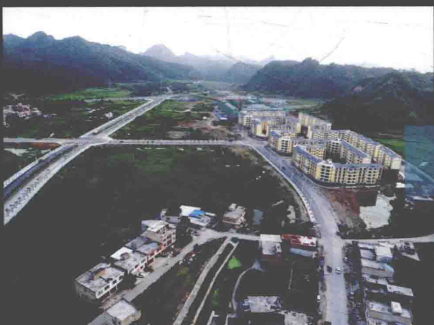
贵州九阡镇路网工程
