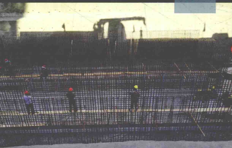
乌鲁木齐道路工程施工现场
