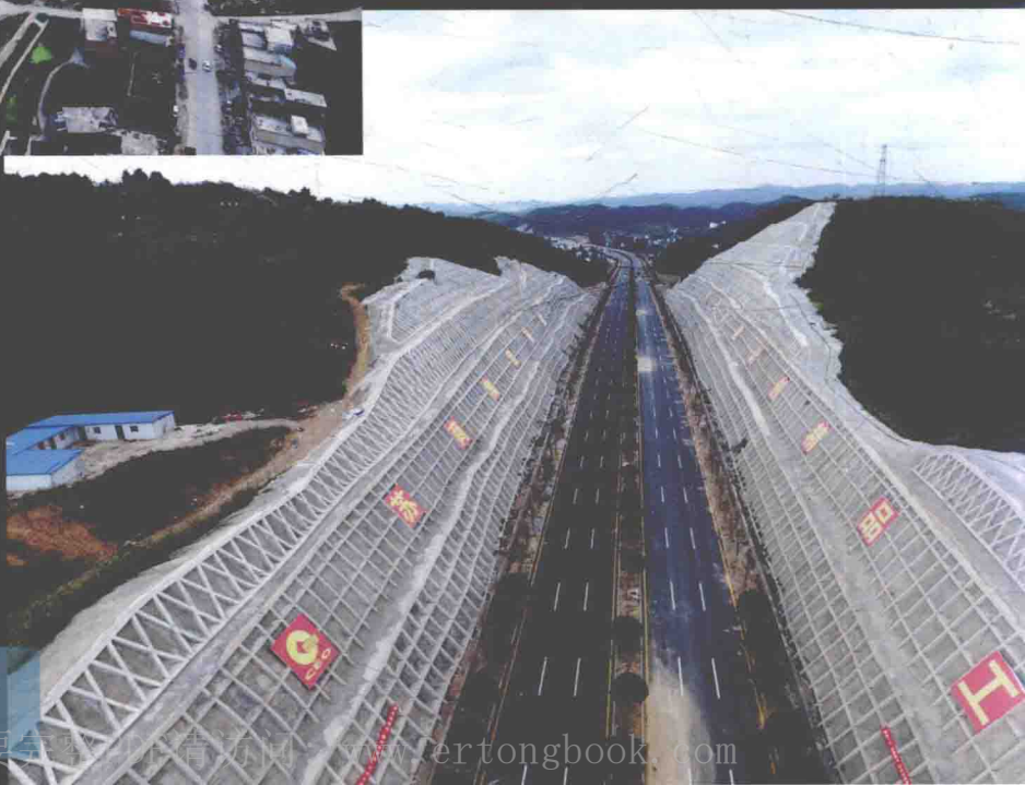
贵州修文扎久城市主干道竣工通车
