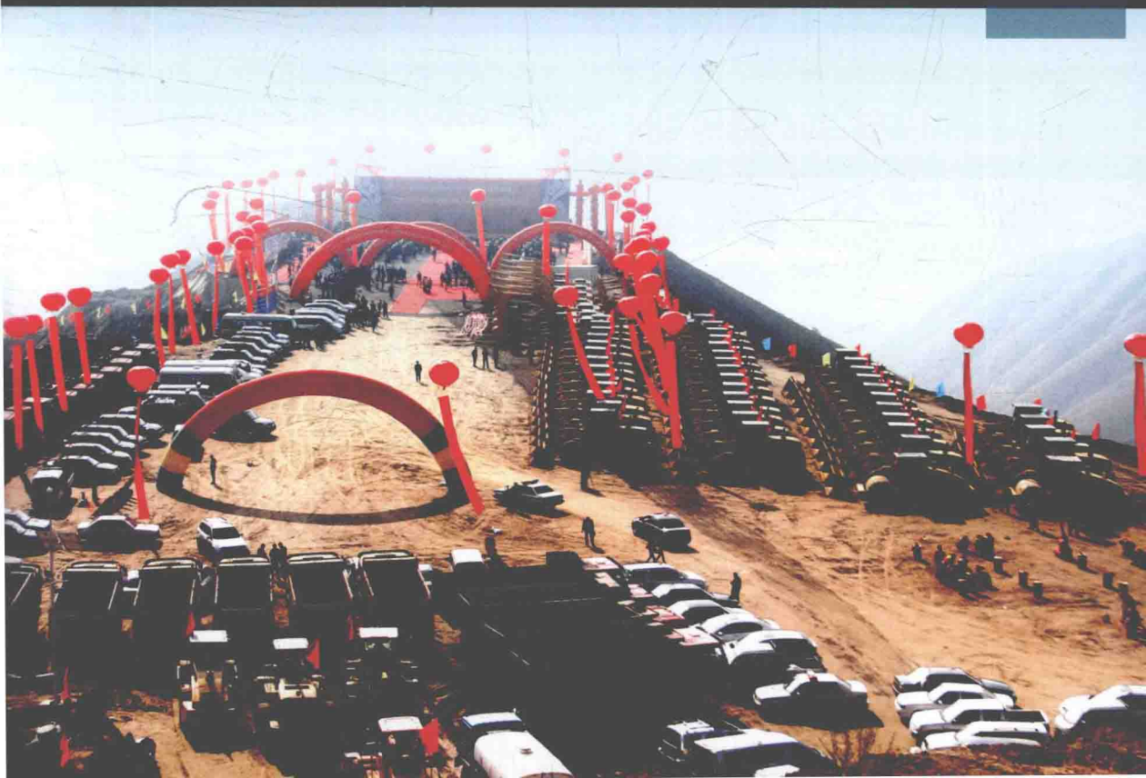
甘肃兰州 新城项目 开工仪式 现场
