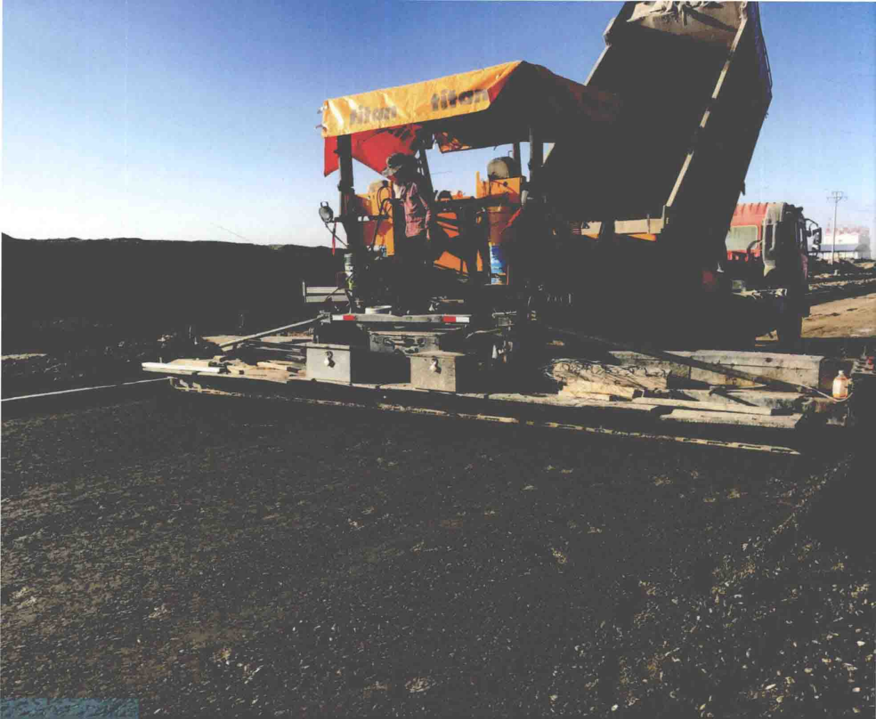
新疆维吾尔自治区阿克苏项目施工现场
