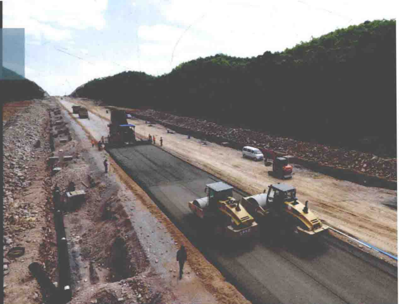
四川 PPP 项目 工地铺设水稳
