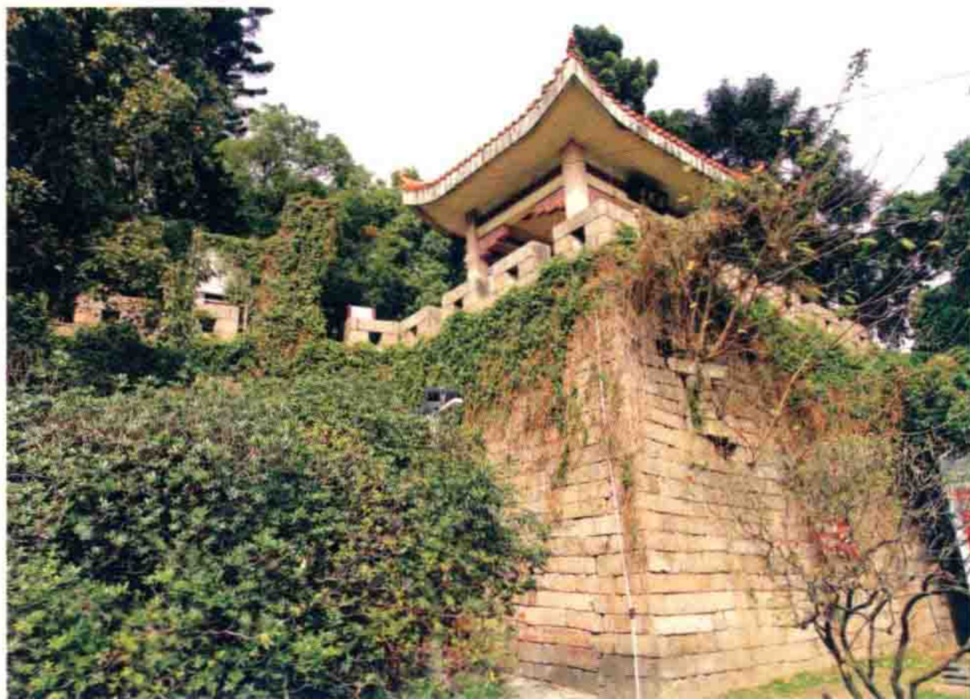
◁ 福州城墙一角 本文照片除署名外，均由杨昊玉、盛钺摄
