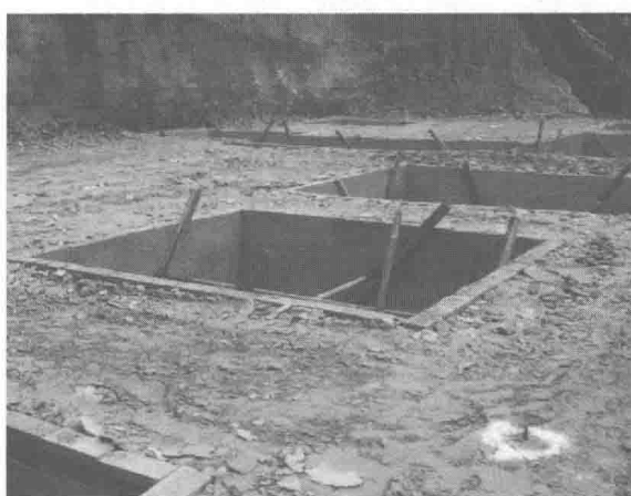
图 1-11 垫层底部土方平整
