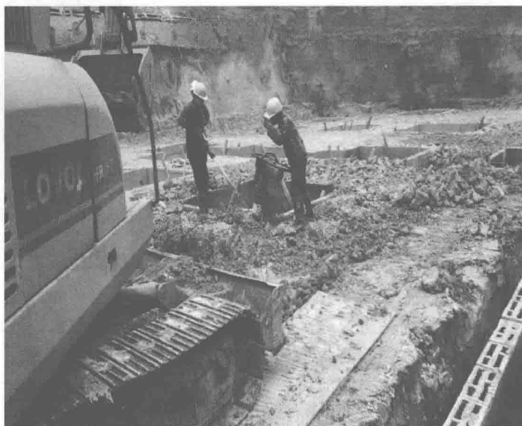
图 1-10 垫层底部土方夯实
