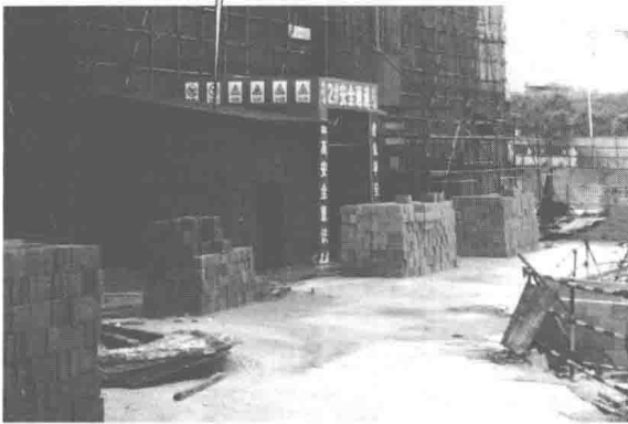
图 1-7 临时仓库存储保管材料
