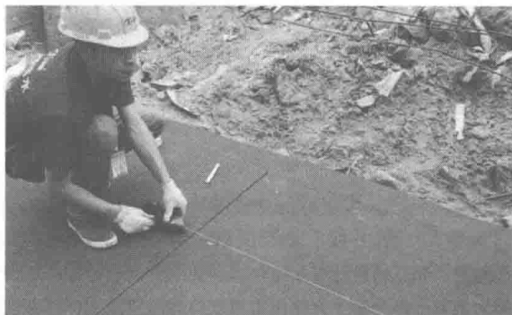
图 1-13 卷材铺贴定位、弹线
