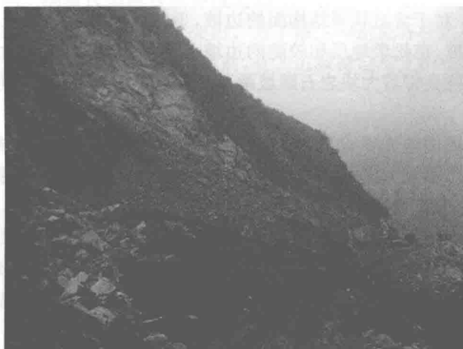
(b) 睢水至高川公路沿线的崩塌、滚石及被砸烂的车辆
