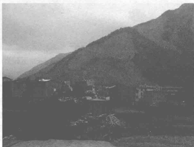
(a) 陈家坝主大街上的断桥及掩埋大量建筑物的大型滑坡
