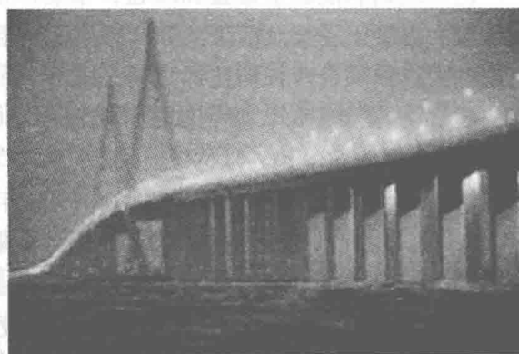
图 0-1-6 世界第三长跨海大桥—— 杭州湾跨海大桥
