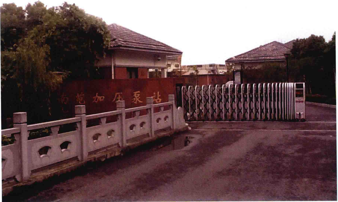
南苑供水加压泵站(规模4万立方米/日、2010年8月建成运行)
