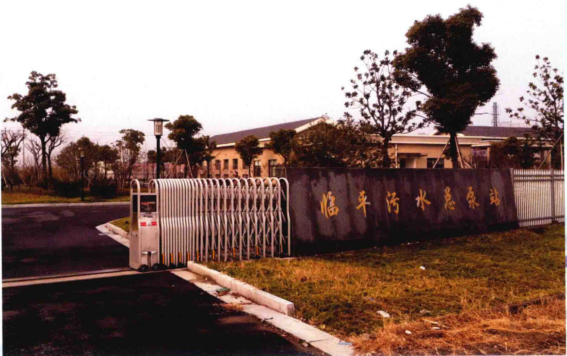
临平污水总泵站(一期规模25万吨/日、2013年5月建成运行)
