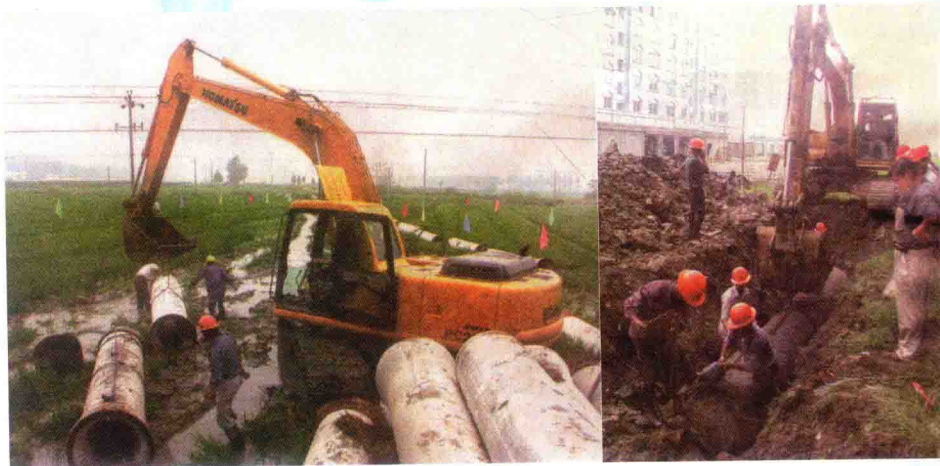
建设中的临平、塘栖供水工程——铺设供水管道
