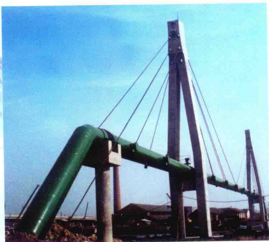
管长50米、重35吨的DN1400横跨运河输水管桥
