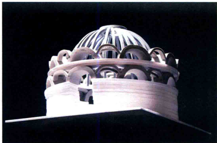
罗马万神殿 | 意大利·BC27 建筑师/结构师：不明 万神殿的结构内部有着隐藏的拱群。(52页)
