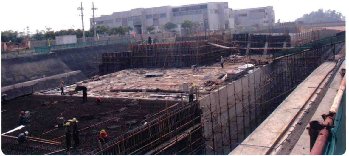
仑头隧道岸上段明挖主体结构施工
