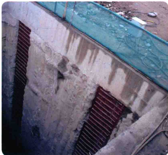
仑头隧道格栅式地下连续墙护岸结构接头处理
