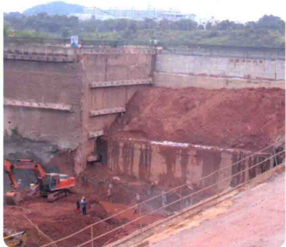
官洲隧道最终接头二次围堰完成效果
