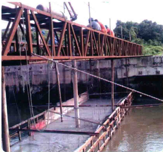
官洲隧道最终接头二次围堰水下混凝土施工
