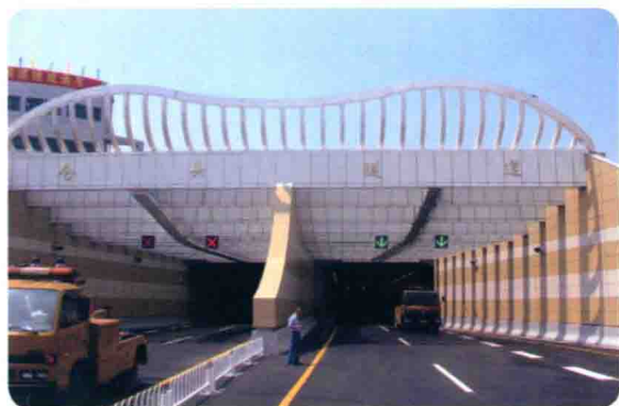
仑头隧道洞门
