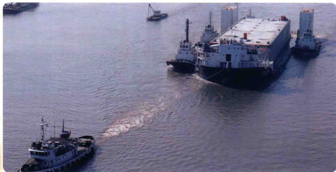
仑头隧道管段拖航
