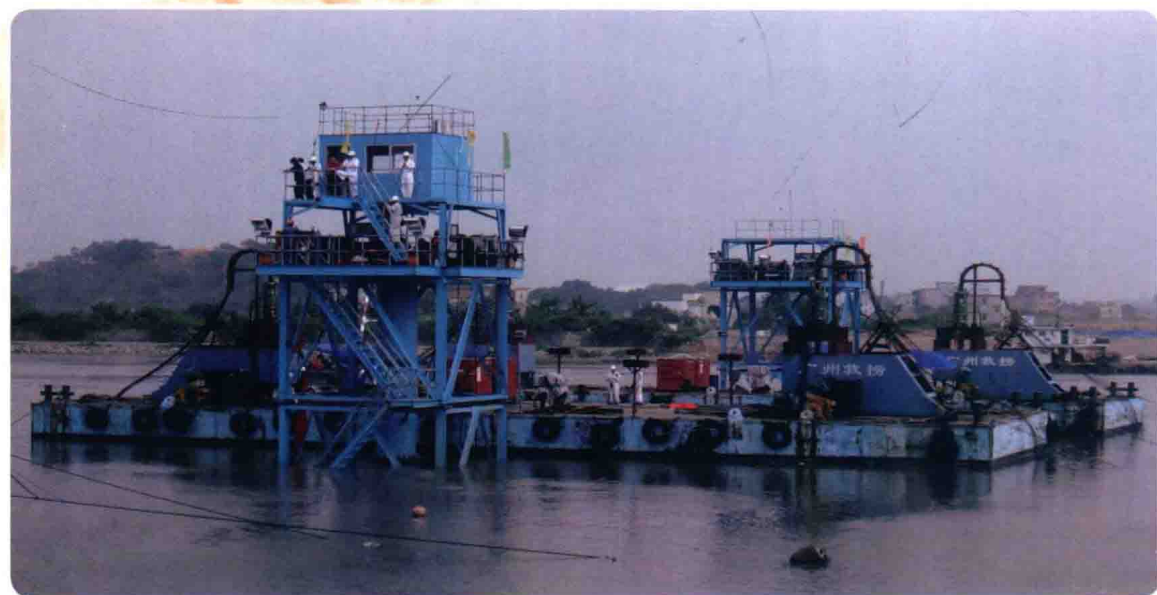
仑头隧道管段沉放对接
