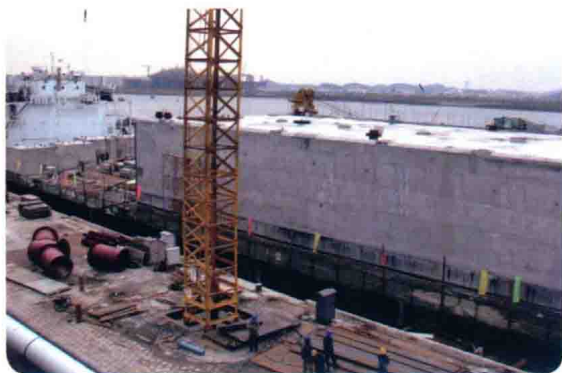
仑头隧道移动干坞预制管段
