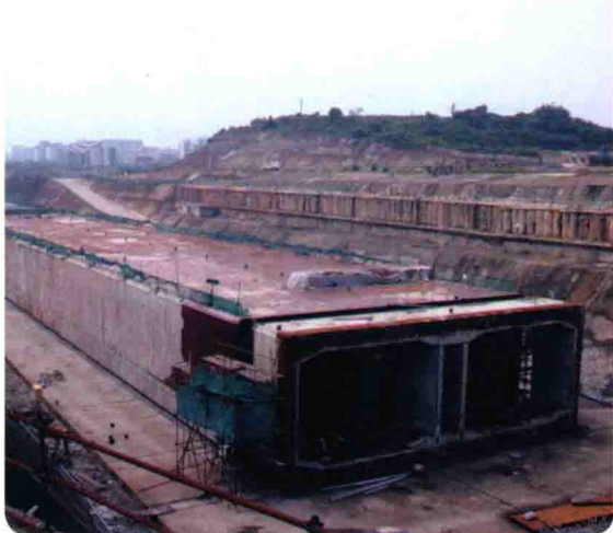
官洲隧道轴线干坞预制管段
