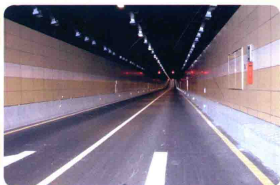
官洲隧道内部装修
