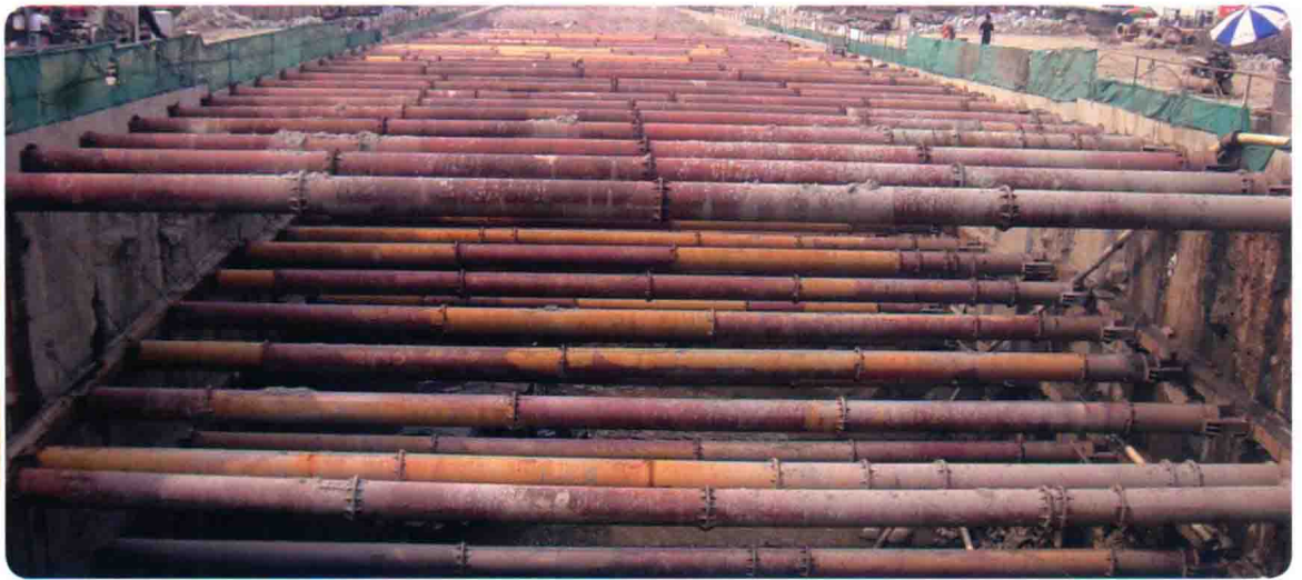
仑头隧道岸上段明挖围护结构施工
