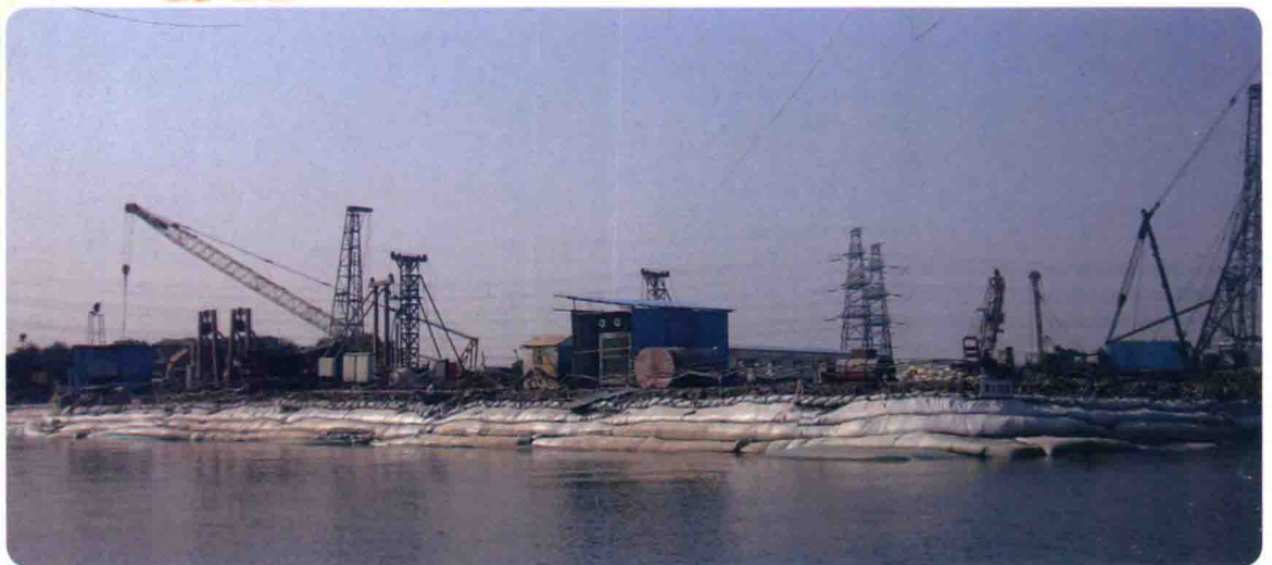
仑头隧道模袋砂围堰
