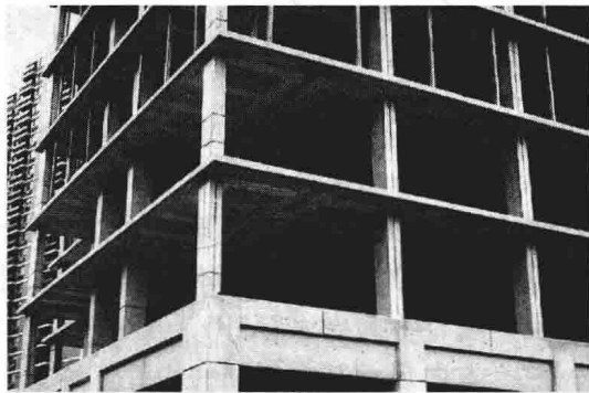
图 1-1 现浇混凝土房屋
