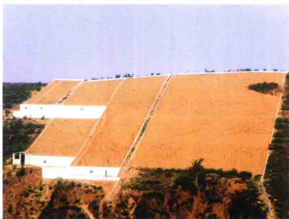
崩坡水土流失监测
