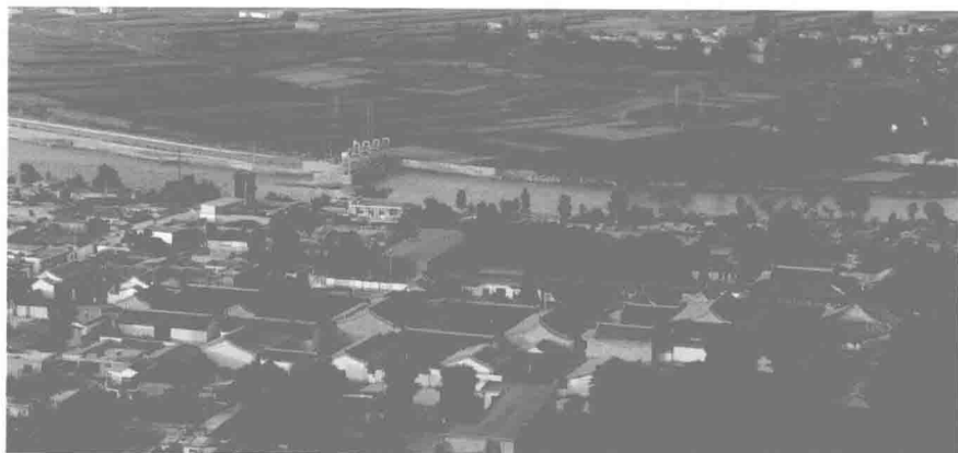
衙门建筑群全景
