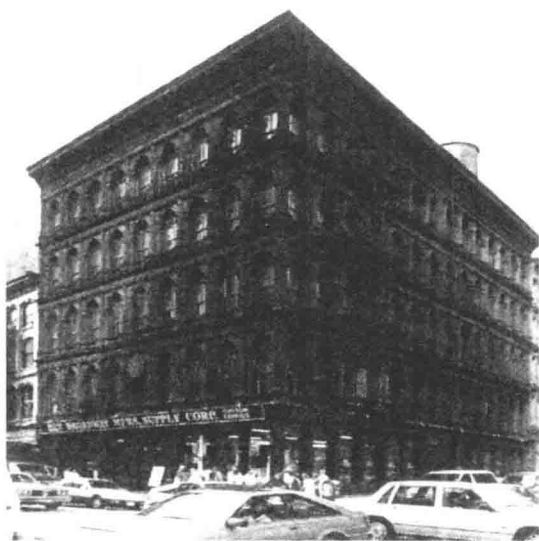
图10 位于纽约的豪沃特大厦 (Haughwout Building)
