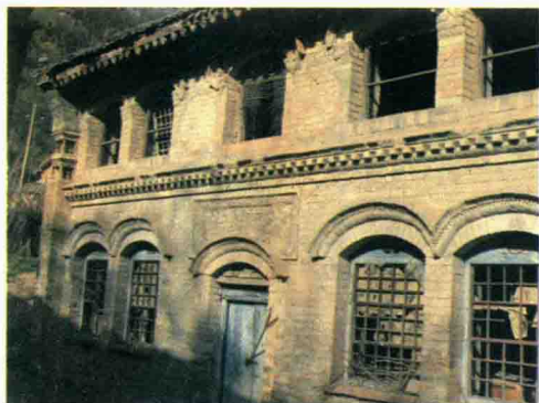
小洋楼正面建筑
