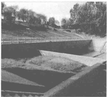
图 2-5 潘庄引黄闸闸后照
