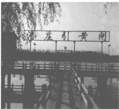
图 2-4 潘庄引黄闸正面照
