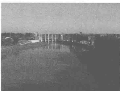
图 2-12 打渔张引黄闸闸后照
