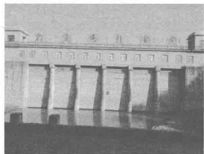
图 2-11 打渔张引黄闸闸前照
