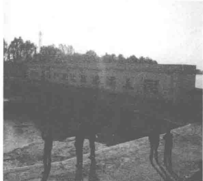
图 2-10 打渔张引黄闸老闸
