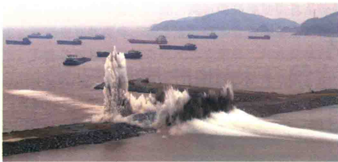
图1-8 福建莆田填海项目侧向水下爆炸挤淤（中国建筑第八工程局）
