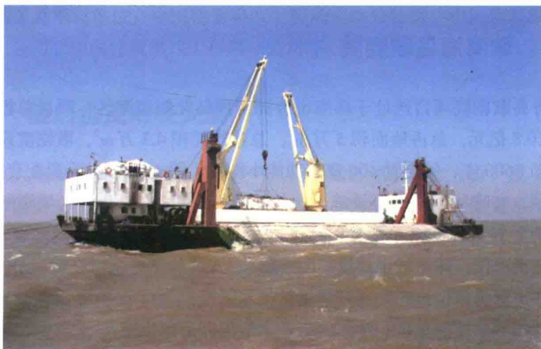
图1-7 福建莆田填海项目水上铺排船（中国建筑第八工程局）
