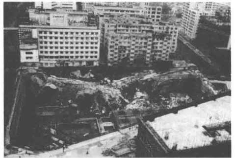
图 1.1-6 广州建筑基坑坍塌事故
