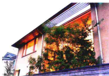
图 1-1-2 真间川住宅外观
