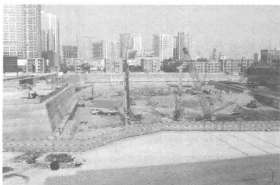
图 1-1 央视 CCTV 基坑工程(排桩 + 土钉墙)
