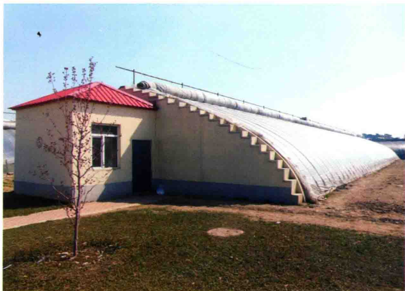
日光温室外部
