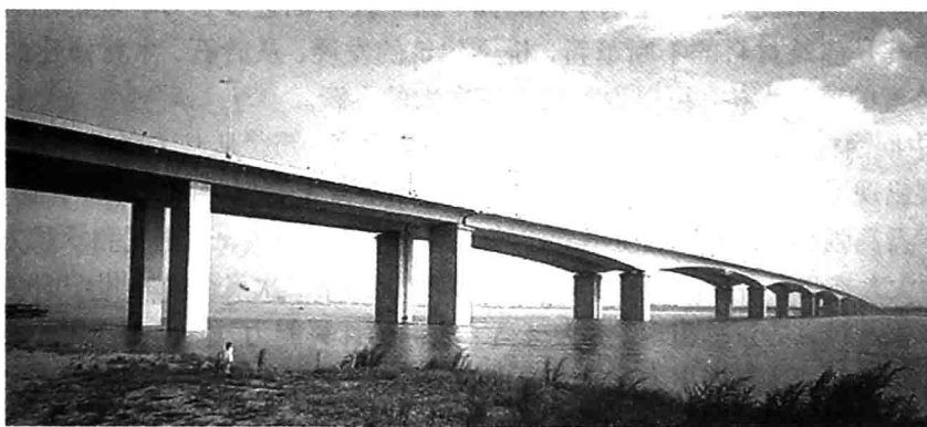
2001 年 7 月建成，主跨为 (90+3 \times 165+90) m，是我国目前跨径 最大的预应力混凝土连续梁桥，在同类型桥中居亚洲第 1。
