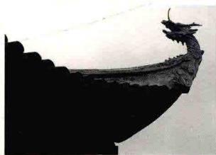
我国传统建筑檐部形式之一。屋檐上翘，若飞举之势，常用于亭、台、楼、阁、庙宇、宫殿等建筑上。
