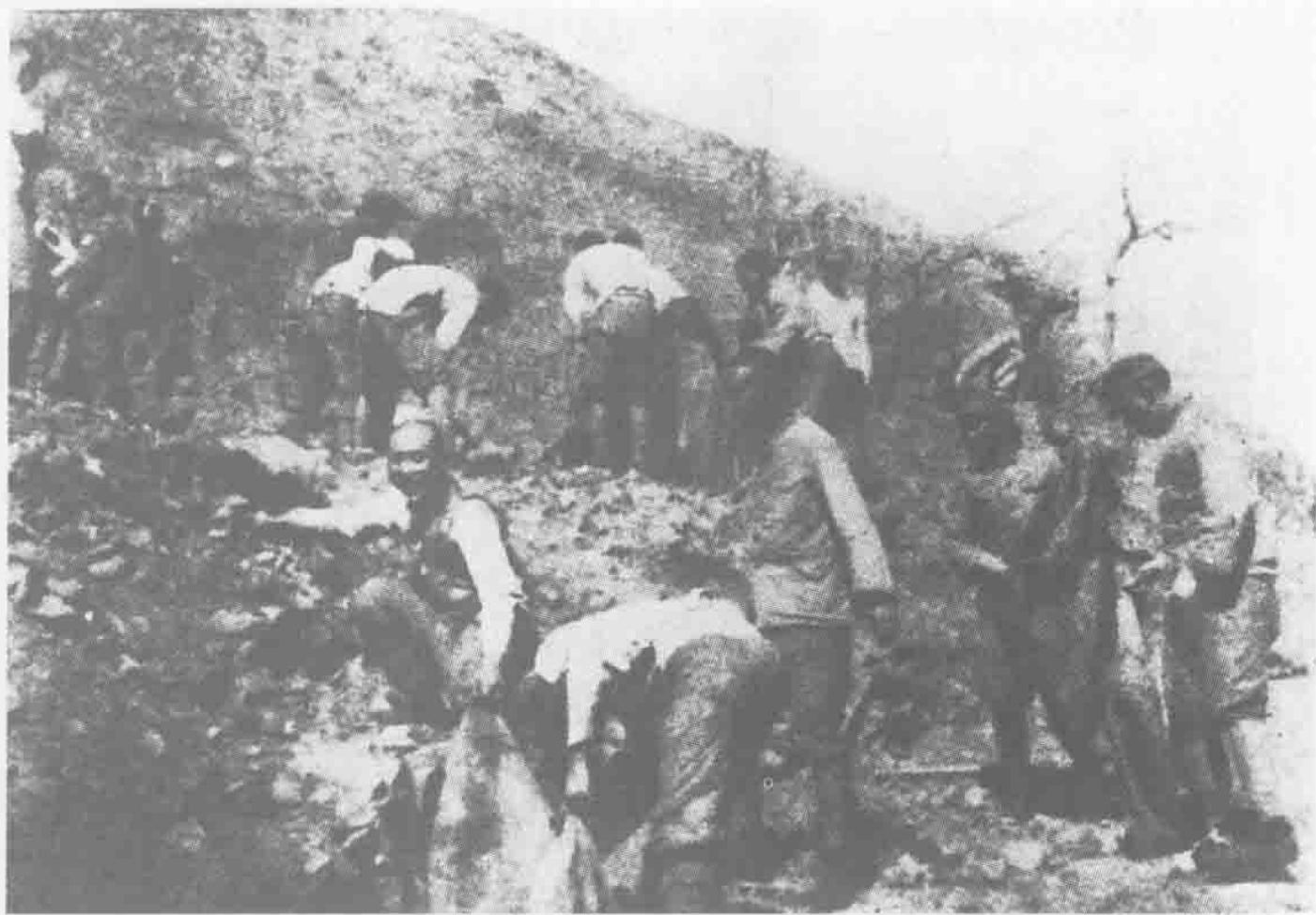
第十七军在 古北口之南天门 修筑工事
